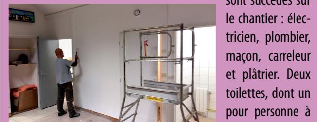
sont succédés sur le chantier : électricien, plombier, maçon, carreleur et plâtrier. Deux toilettes, dont un pour personne à mobilité réduite sont refaits. Les portes d'accès sont remplacées par des modèles plus larges (100 cm au lieu de 75 cm). Un coin cuisine a été aménagé pour améliorer la fonctionnalité. Pour finir le vélux a été changé et une VMC a été installée.
